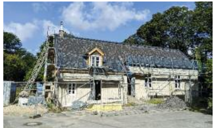
Restaurierung der Arbeiterwohnhäuser am Eisenhammer im Deilbachtal
